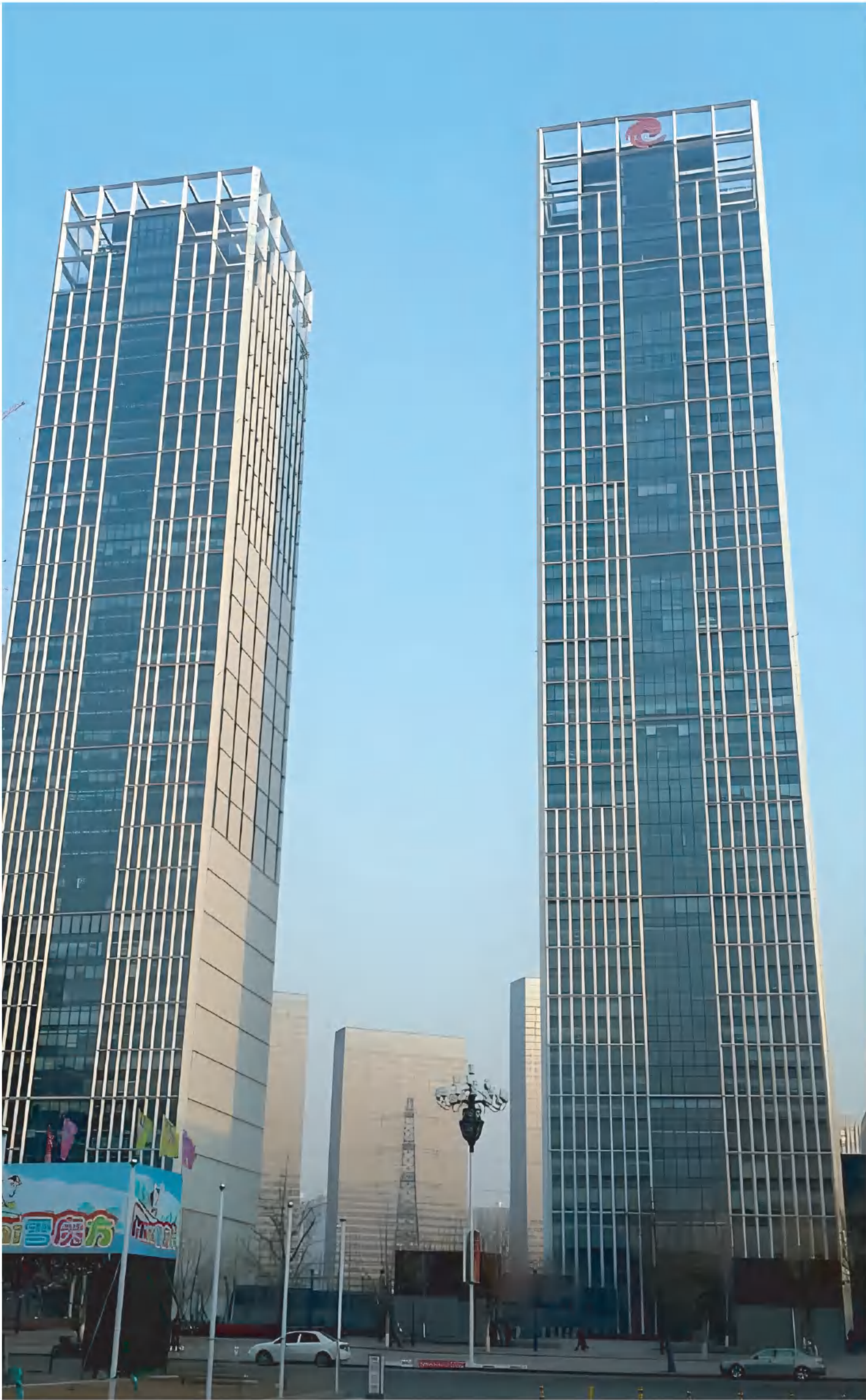
DALIAN-Futures Building Construction Areas: 40000 square Meters Product Series: OA500 Steel Access Floor Panel 工程名称: 大连·大连期货大厦 工程面积: 40000平方米 产品系列: OA500钢质网络活动地板
