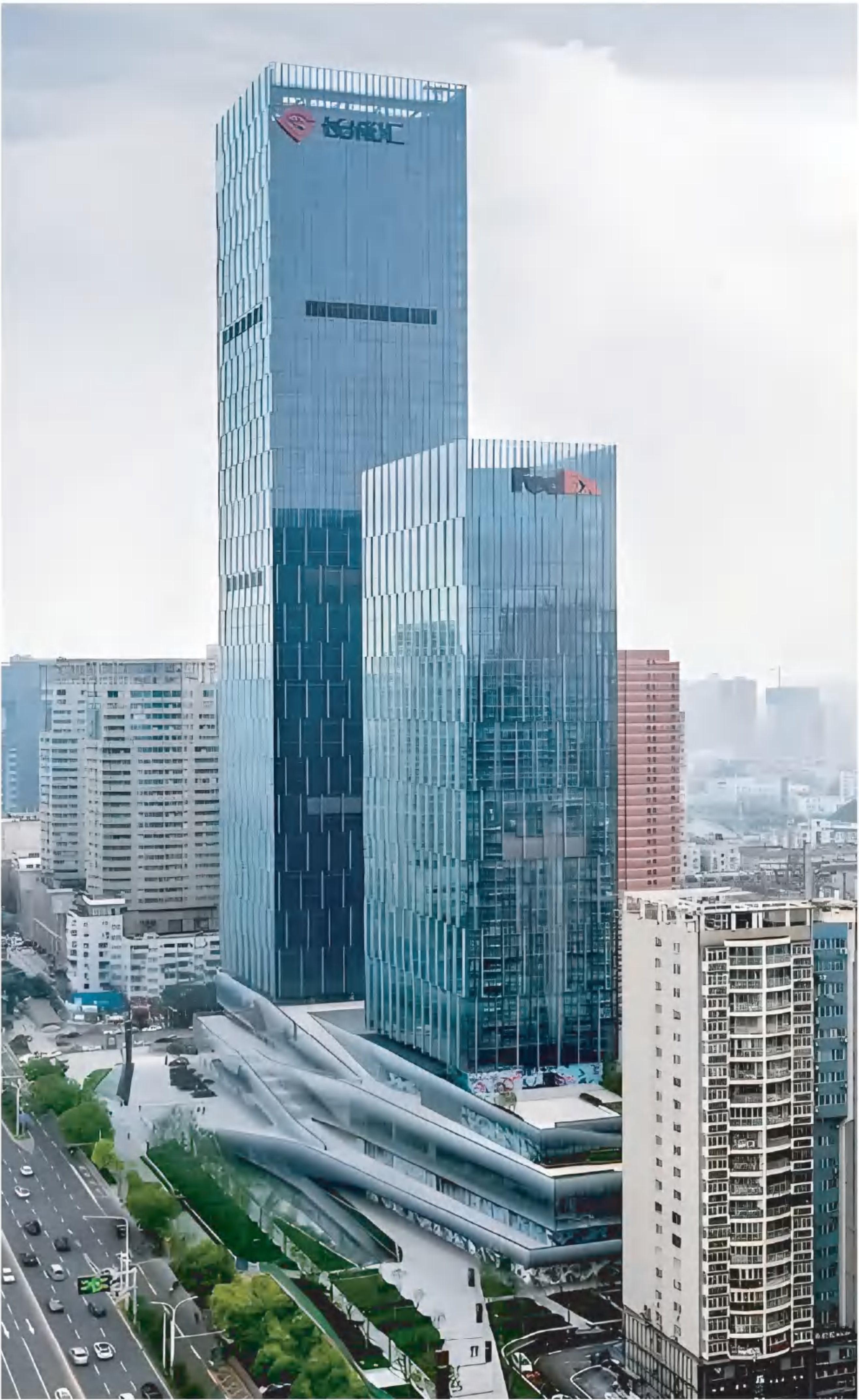
WUHAN-The Grate Wall Remittance Building Construction Areas: 30000 square Meters Product Series: OA600 Steel Access Floor Panel 工程名称: 武汉·长城汇 工程面积: 30000平方米 产品系列: OA600钢质网络活动地板
