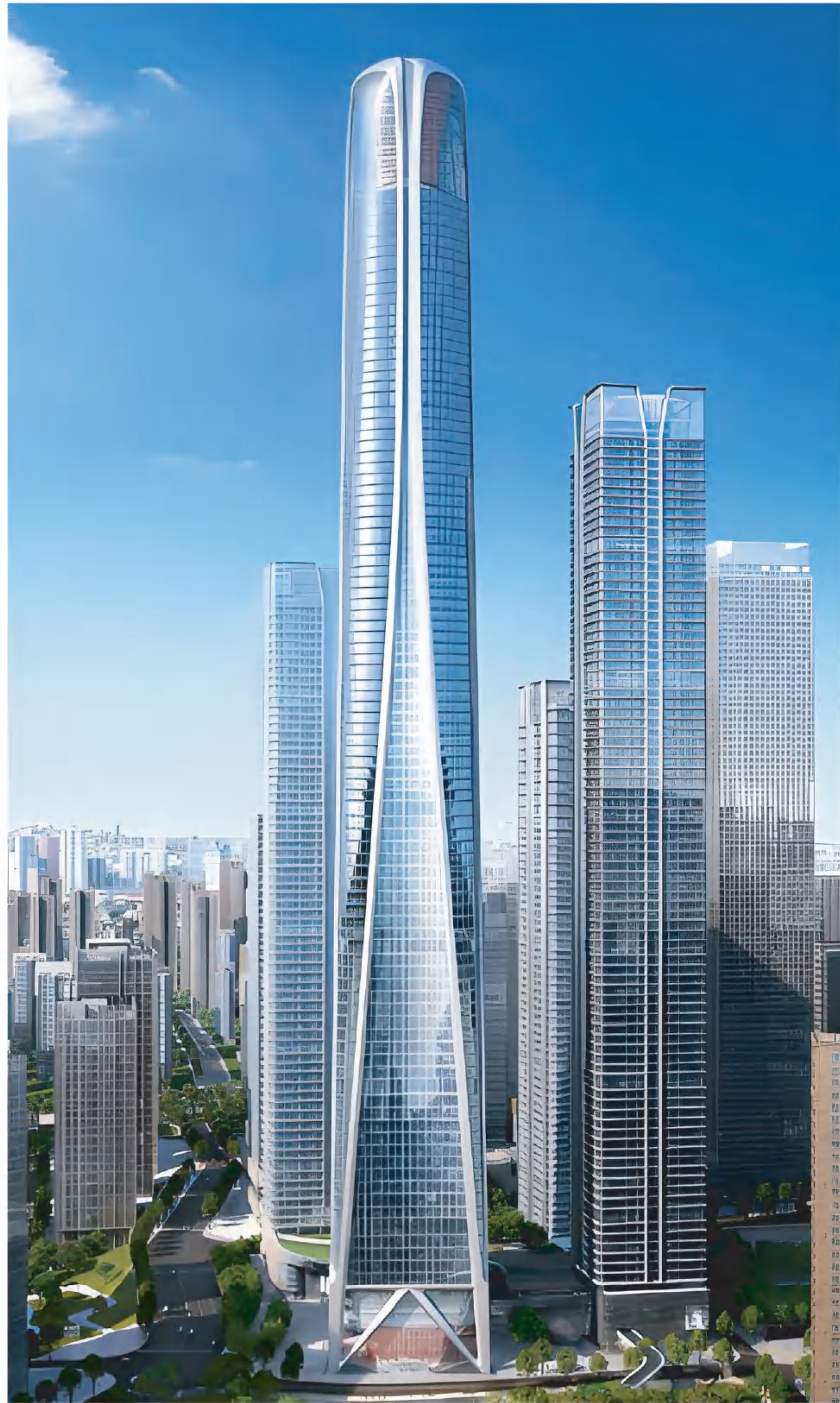
CHONGQING-Jiangbeizui Amount Center Construction Areas: 50000 square Meters Product Series: OA500 Steel Access Floor Panel 工程名称: 重庆·江北嘴金融中心 工程面积: 50000平方米 产品系列: OA500钢质网络活动地板
