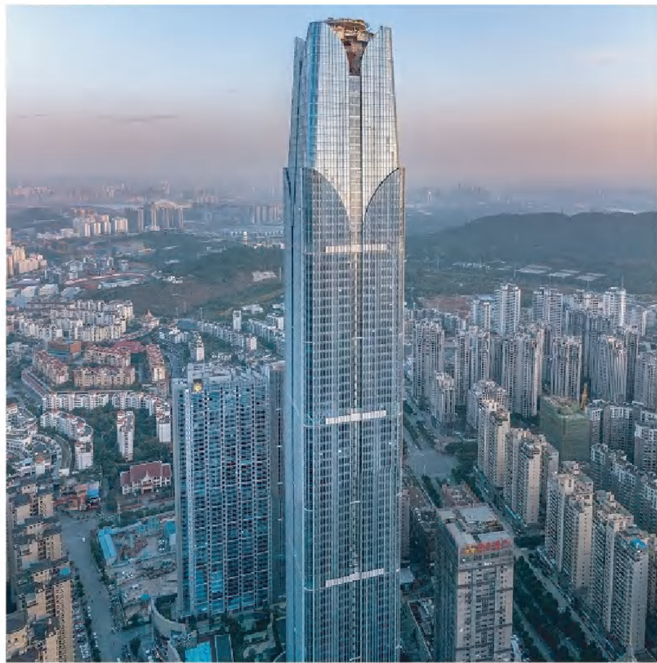
NANNING-Nanning Dragon Optical Century Construction Areas: 97000 Square Meters Product Series: OA600 Steel Access Floor Panel 工程名称: 南宁·龙光世纪 工程面积: 97000平方米 产品系列: OA600钢质网络活动地板
