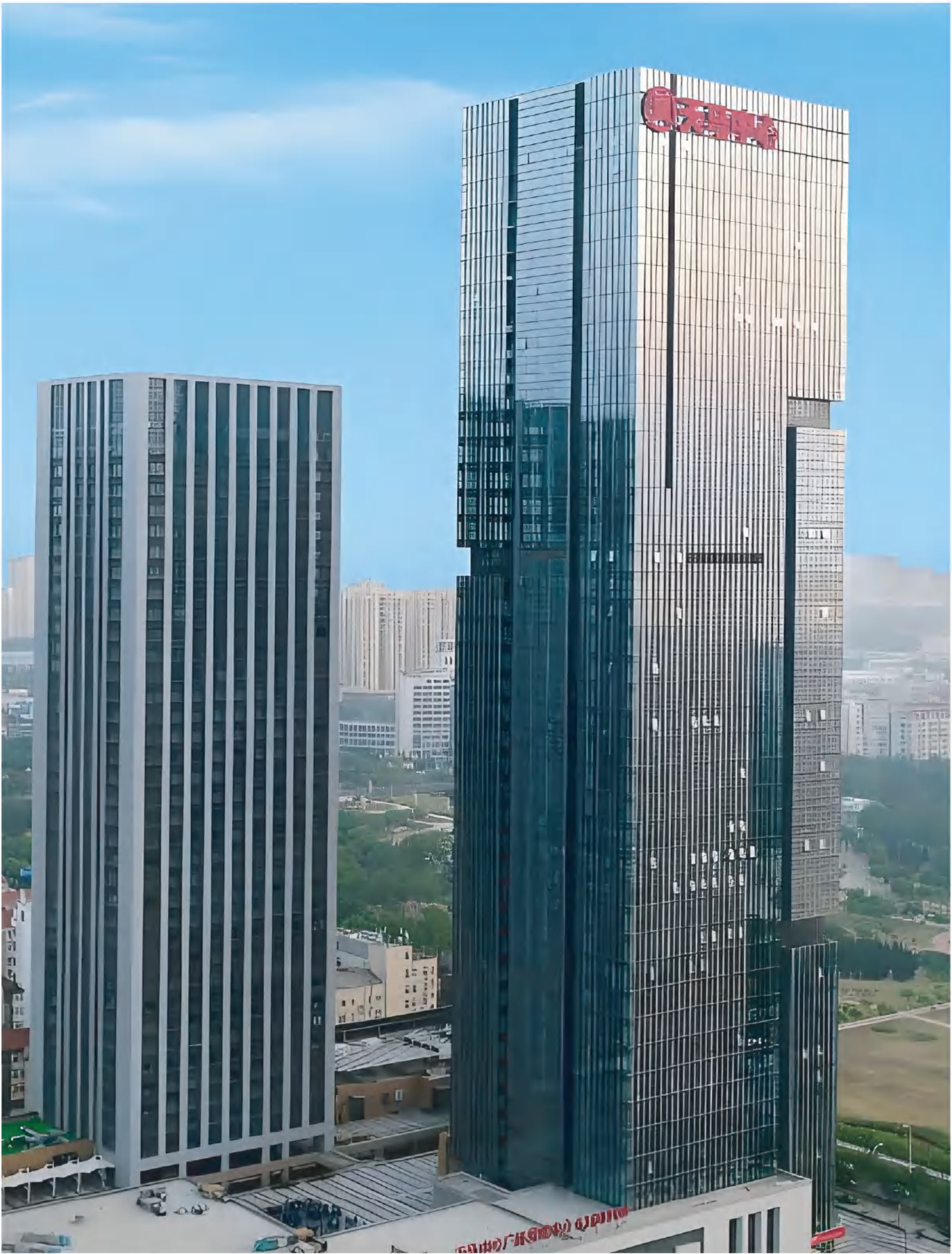
YANTAI-Tianma Center Construction Areas: 45000 square Meters Product Series: OA600 Steel Access Floor Panel 工程名称: 烟台·天马中心 工程面积: 45000平方米 产品系列: OA600钢质网络活动地板
